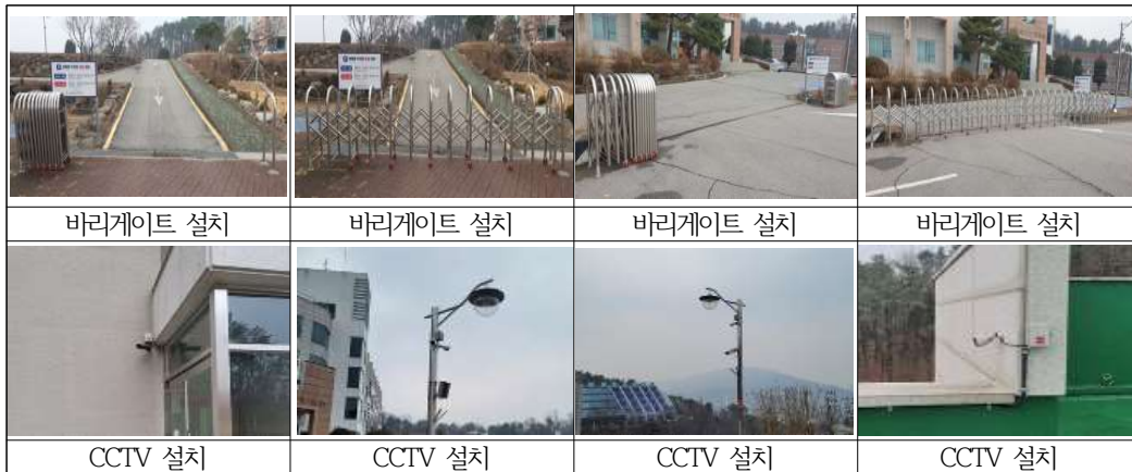
[사진 4.5.3-7] 생활관 바리게이트 및 CCTV 설치
