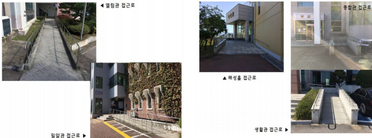
[사진 4.3.2-6] 건물 출입구 접근로
