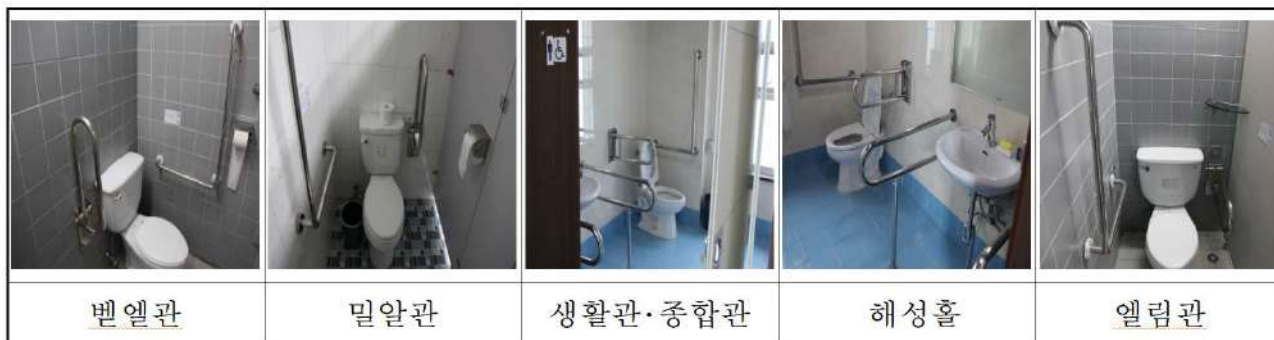
<사진 4.3.6.1-9> 각 건물 위생시설
